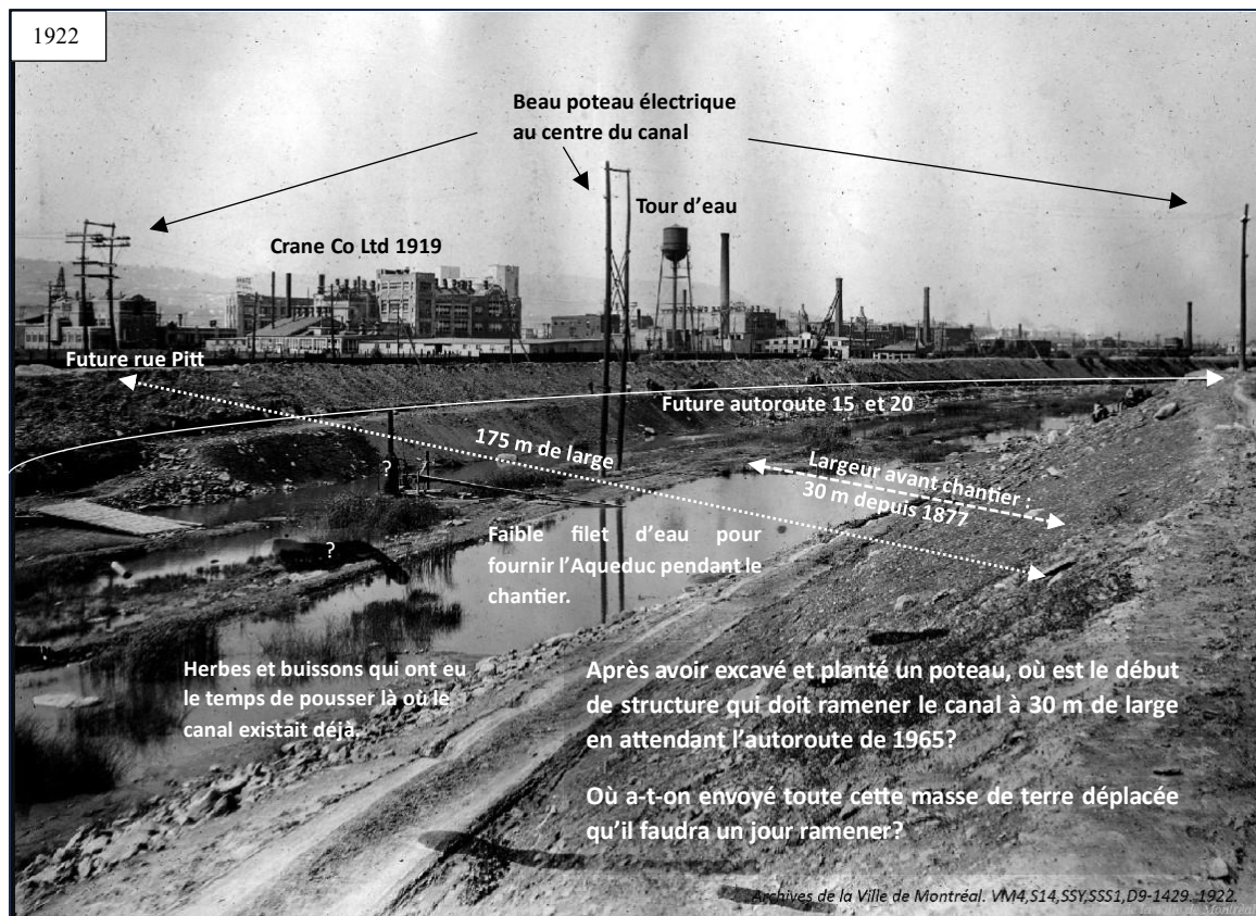
Photo 41 – Étrange chantier en 1922 dans le secteur de Verdun pour améliorer et agrandir la structure du canal de l'Aqueduc 11
